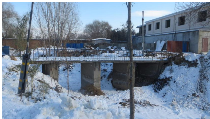
图 2-4 涇阳驿 2 号桥现状照片
