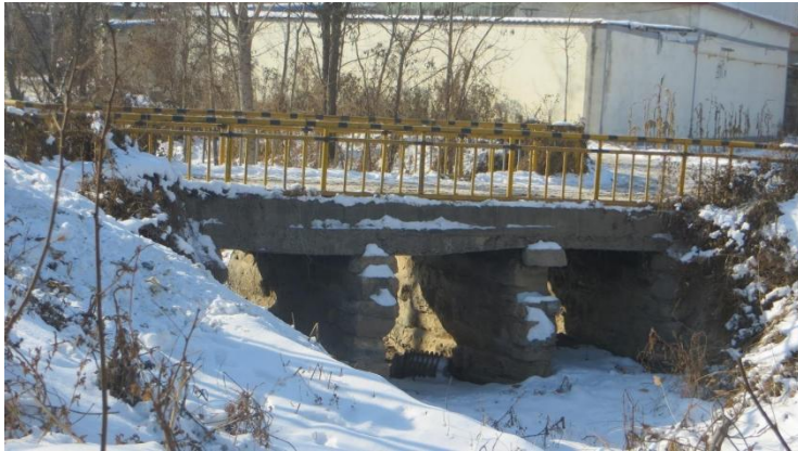
图 2-3 方顺村东桥现状照片
